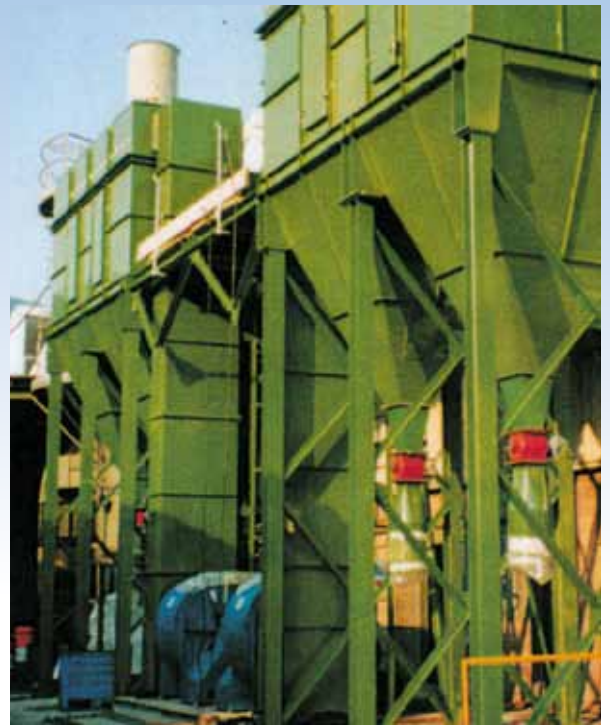
Dépoussiéreur avec éléments filtrants de dépoussiérage.
