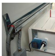
► Vanne pour isolement d'un module (en option)
