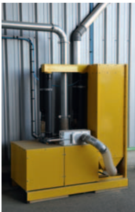
Figure 5. Exemple de transfert automatisé du contenu du bac dans le réseau de ventilation des machines fixes
