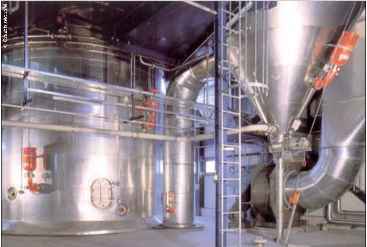
Photo 10 ● Visualisation partielle d'un système de protection. Suppression d'explosion sur tour d'atomisation et filtre avec découplage de la gaine de liaison.
