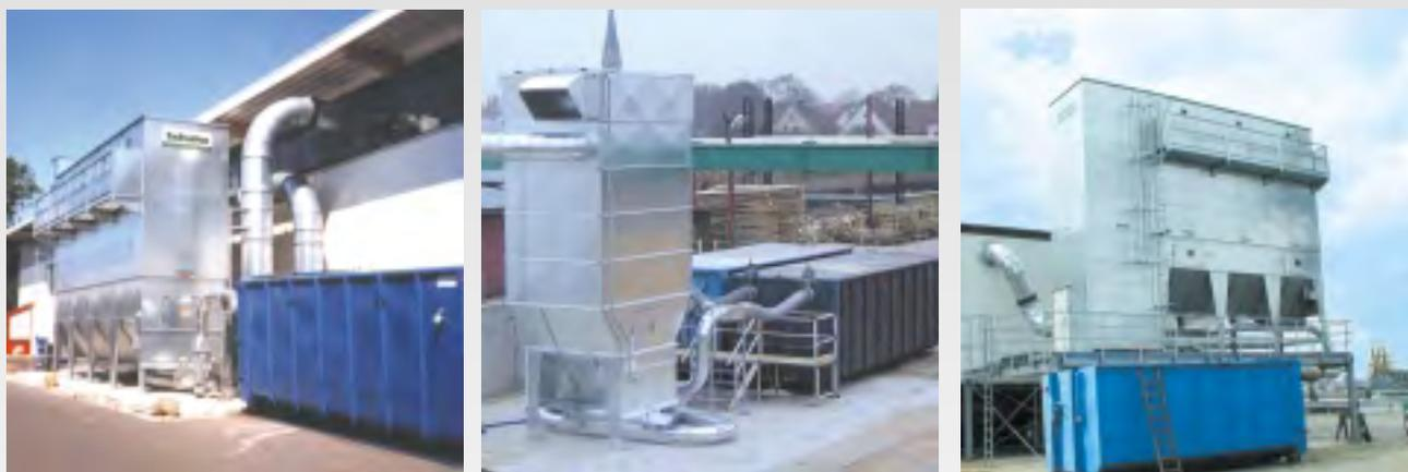
La polyvalence et la capacité de rendement des installations de filtration de Schuko restent inégalées. Elles peuvent aussi bien être mises en œuvre comme filtre en zone de surpression que comme filtre en exploitation sous vide. Le système d'extraction peut être adapté aux zones d'utilisation respectives.
