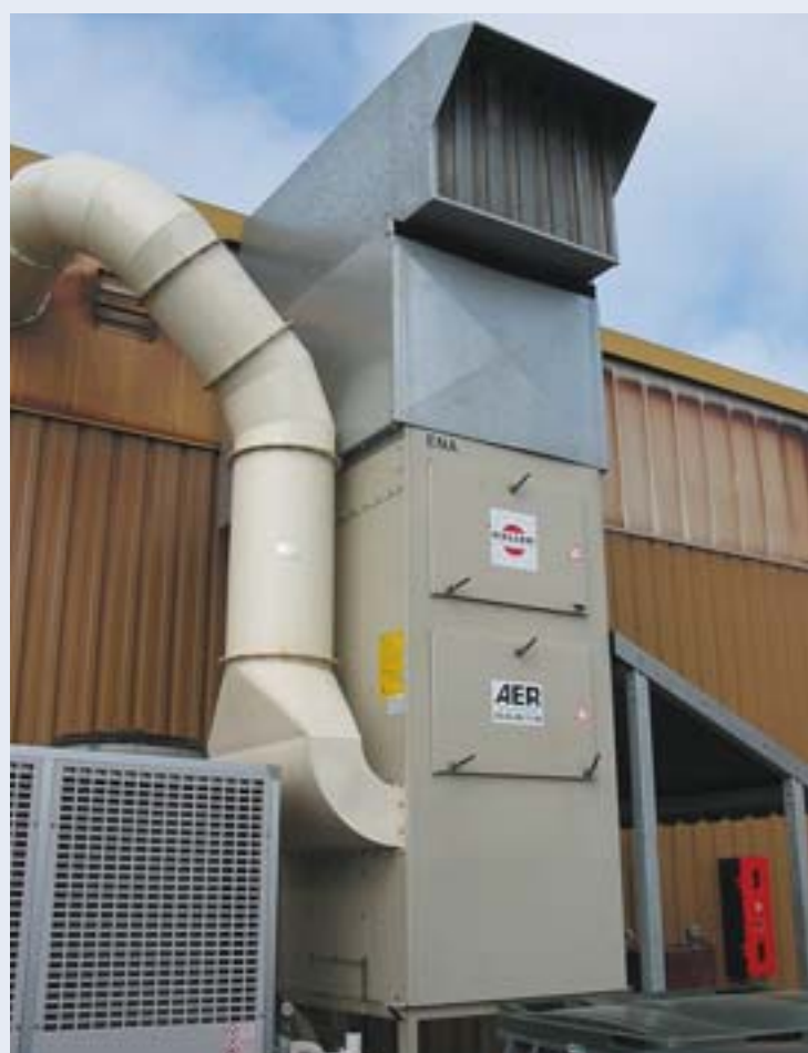
Photo 23. L'air pollué est filtré, puis rejeté vers l'extérieur. Les éléments filtrants sont constitués de couches de fibres d'acier. Un rinçage automatique du séparateur est effectué toutes les 4 heures à l'eau et avec de l'air comprimé.
