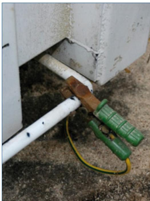
La liaison à la terre et les interconnexions doivent être vérifiées régulièrement (à prévoir au minimum lors des vérifications électriques périodiques réglementaires).
