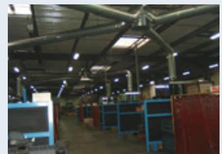
Fig. 34. Vue générale de l'installation.
