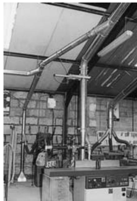
**Raccordement de trois machines.** Les conduits des machines les plus utilisées (corroyeuse, toupie, perceuse) sont équipés de volets d'ouverture et de fermeture asservis électropneumatiquement au fonctionnement de la machine. Les autres machines sont équipées de volets manuels (pour une question de coût d'investissement).
