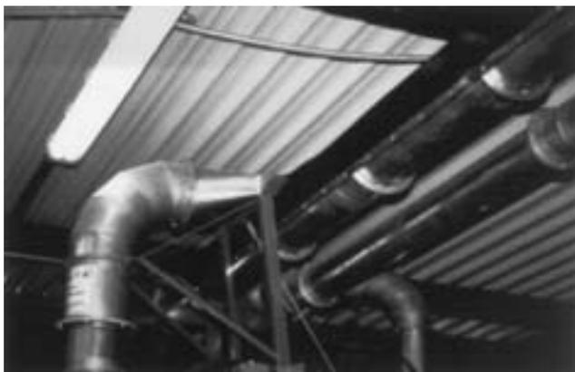
Fig. 11. Exemple de conduits à lèvres
