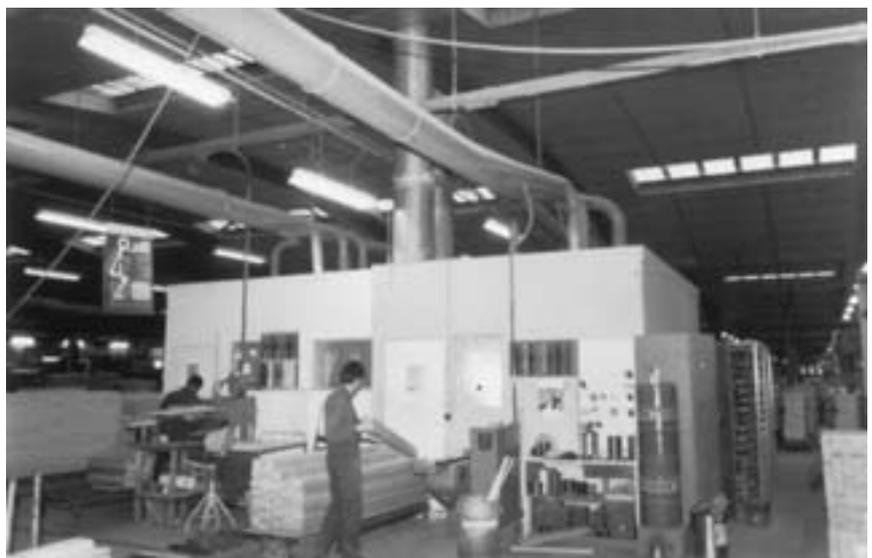
Fig. 13. Exemple d'introduction d'air de compensation. Les conduits verticaux introduisent l'air neuf directement dans la cabine
